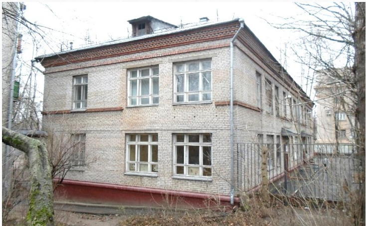
Фото до капитального ремонта
