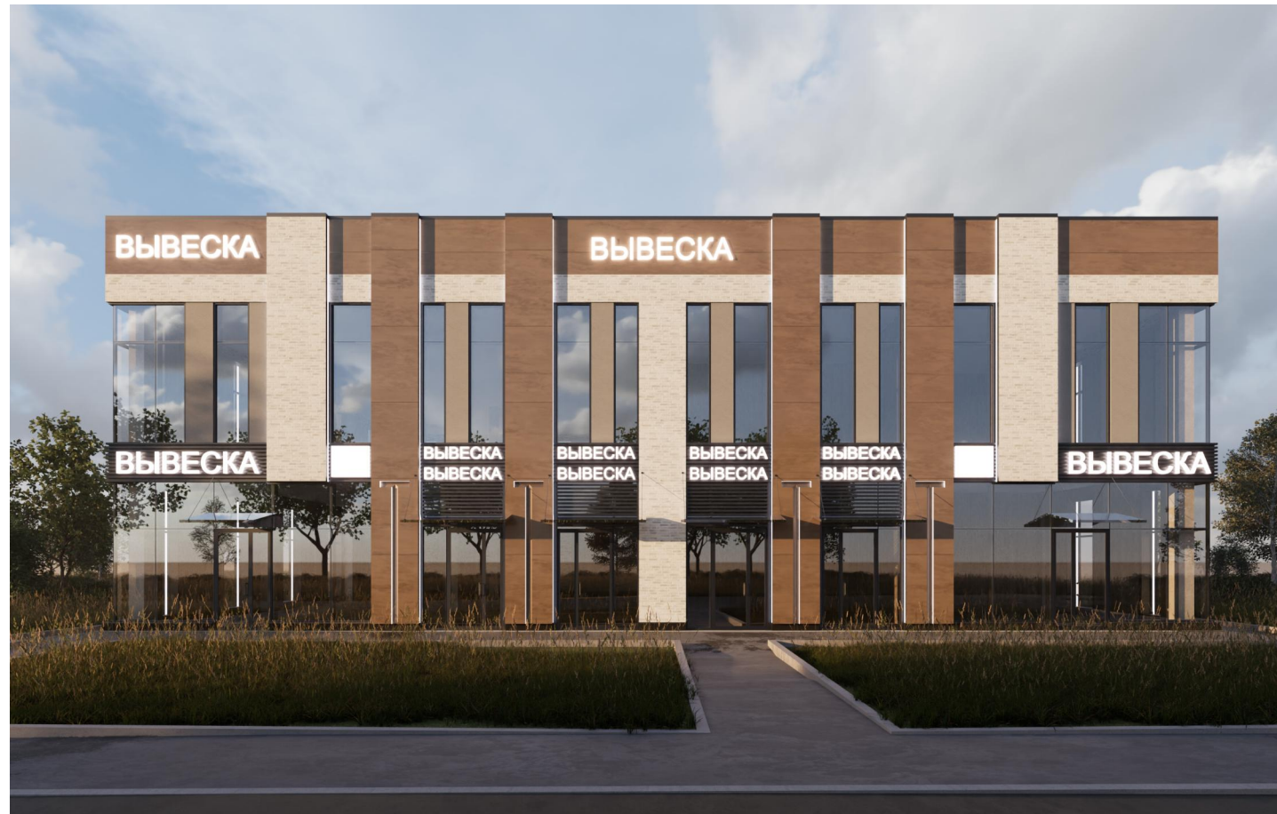
Здание магазина. Ленинградская область
