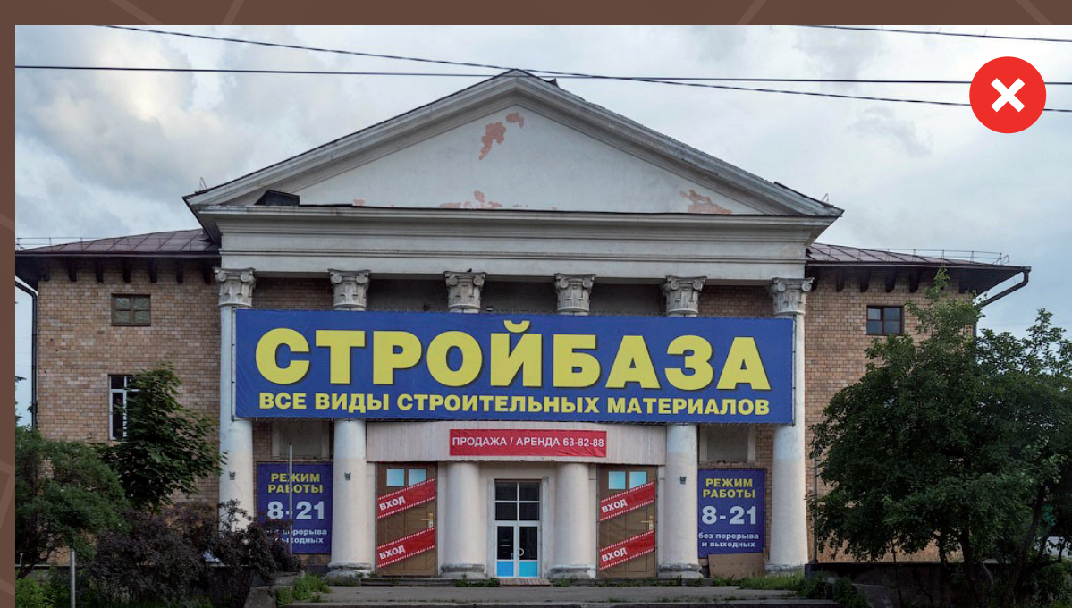
Реклама перекрывает архитектурные элементы фасада.
