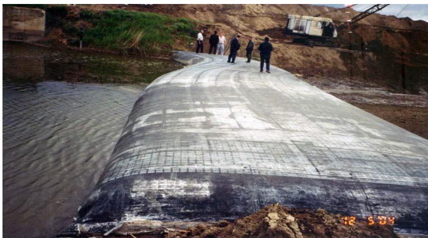
Рисунок 7.3— Быстровозводимая гибкая дамба с высотой 3,0 м, перекрывающая канал Варнавинского водохранилища
